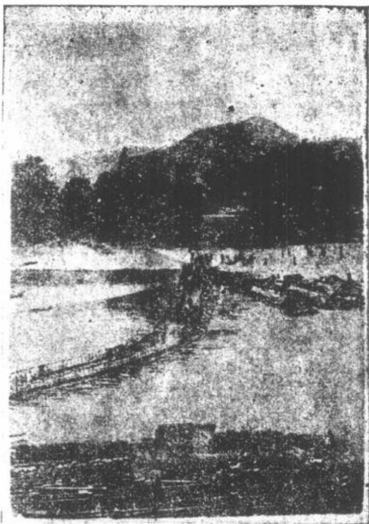
本路軍築成之雅河浮橋
